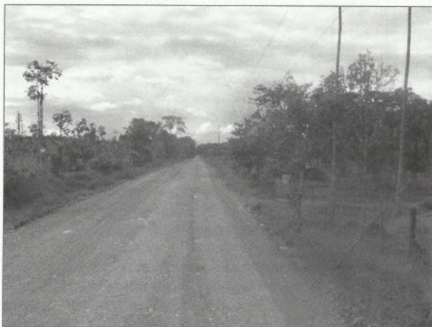
Foto 5. Obra terminada en Colombia de estabilización química de suelos mediante Rocamix.
