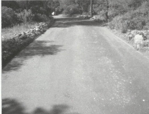
Foto 1. Obra terminada de suelos de la explanada estabilizados químicamente mediante Rocamix, alternativa de costas más bajas que otros métodos tradicionales.
