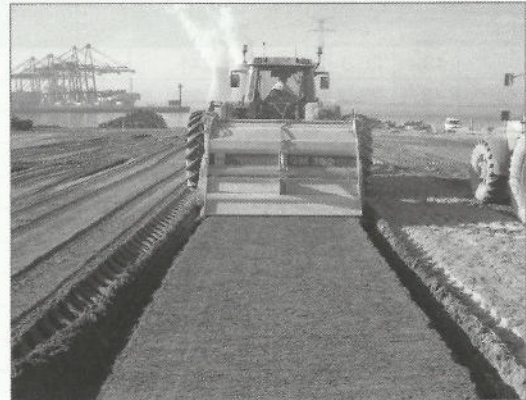
Foto 3. Proceso de mezclado mecánico del suelo con la sal cuaternaria Rocamix. La estabilización conseguida es irreversible y permanente, incluso en presencia de agua.
